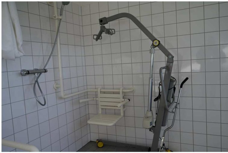
Dorsten, Haldenwangschule, Pflegeraum mit Dusche, WC, Lifter
